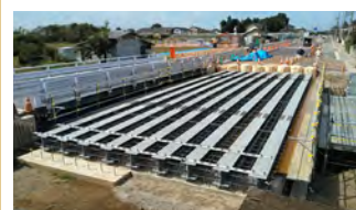
2. 筑西市 女方 江連2号橋
