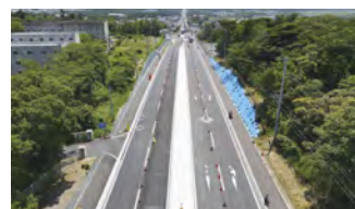
2. 国道245号道路改良工事
