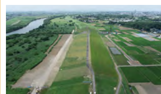
2. 渡良瀬川での堤防工事の完成写真
