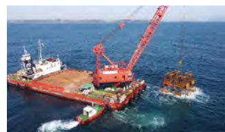
2. 那珂湊漁礁設置工事
