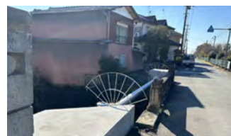
2. 水管橋布設替え工事
