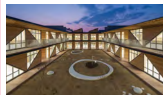
2. 陽光台小学校新築工事
