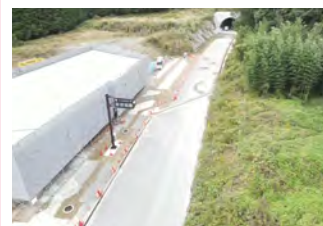
2. 上曽トンネル配電線管路布設工事
