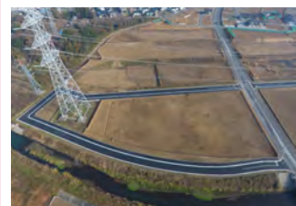
2. 宅地造成工事
