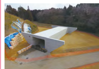
2. 東関道四鹿地区函渠工事
