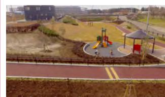
2. 阿見町吉原地区公園整備
