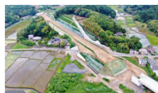
2. R5東関道北高岡地区改良工事
