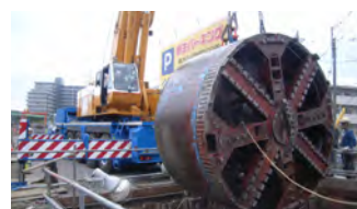
2. 雨水貯留施設工事
