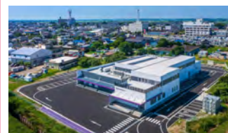
2. 建築工事施工事例
