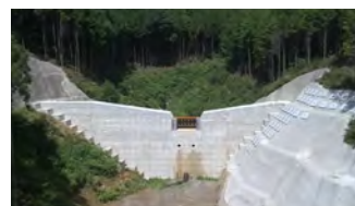
2. 田尻沢砂防堰堤工事
