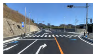
2. 道路改良工事
