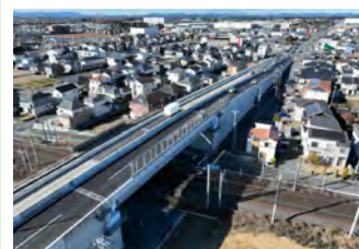
2. 高野橋橋梁修繕工事
