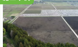
1. 農地整地工事(瓜連地区)
