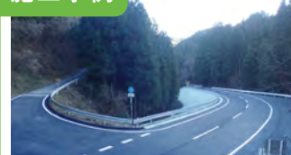
1. 31国補地道道路改舗装工事
