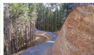
2. 関沢・舟生林道新設工事
