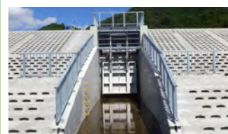
2. 砂防堰堤工事
