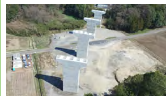
2. 常陸太田市瑞龍町 橋梁下部工事
