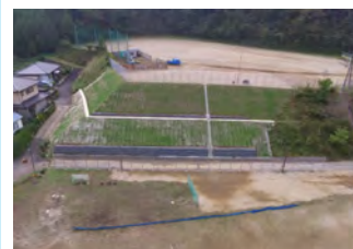
2. 稲田中学校 災害復旧工事
