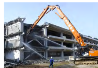
2. 某中学校の解体工事
