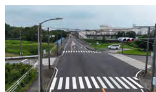
2. 野殿橋橋梁補修工事
