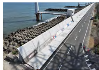
2. 日川海岸高潮施設嵩上工事【神栖市】
