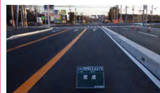
2. 交差点改良舗装工事
