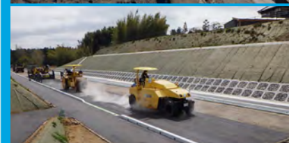
上段: 大洗友部線道路改良工事 下段: 茨城空港アクセス道路舗装工事
