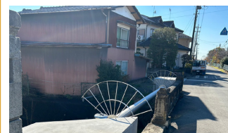
2. 水管橋布代替工事
