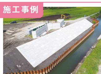
1. 堤防などを補強する護岸工事
