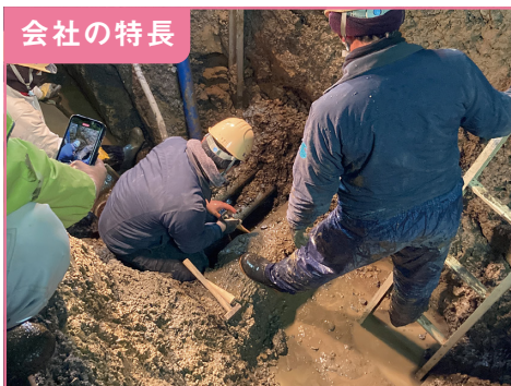
1. 緊急漏水修繕工事の様子
