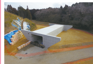
2. 東関東道四鹿地区函渠工事
