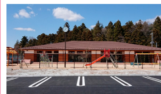
2. 幼稚園新築工事
