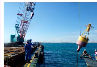
2. 200t吊のクレーン台船による灯浮標入替工事
