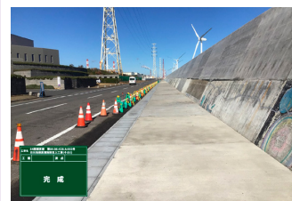
2. 日川海岸高潮施設嵩上工事
