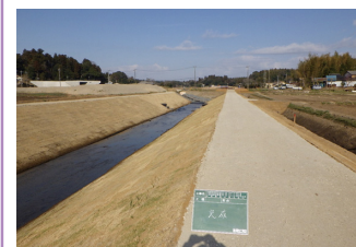
2. 山田川 河道掘削工事
