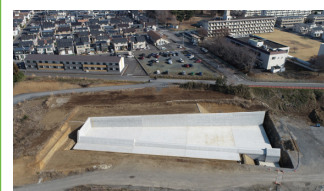
2. 中丸川調整池洪水吐施設
