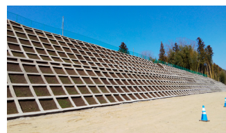
2. 道路改良工事
