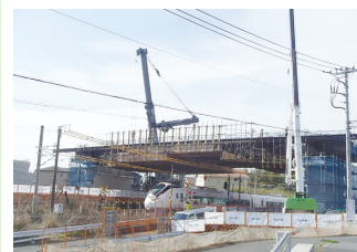
2. 橋梁架設工事
