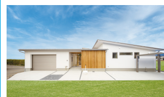
2. 東海村 一般住宅・新築工事
