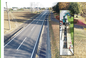
2. 工業用水道事業配水管布設工事
