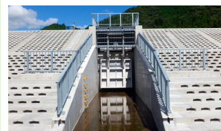
2. 砂防堰堤工事
