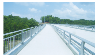
2. 長尾橋 橋梁付属物設置工事
