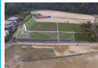
2. 稲田中学校 災害復旧工事
