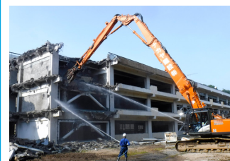
2. 某中学校の解体工事
