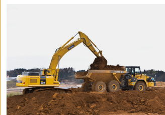
2. 水戸市新ごみ処理施設用造成工事
