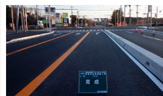
2. 交差点改良舗装工事
