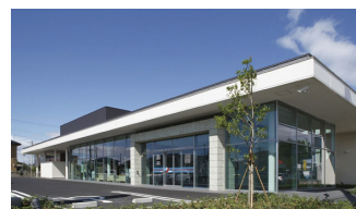
2. 結城信用金庫小山城南支店新築
