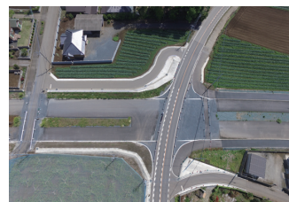
2. 道路改良工事
