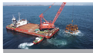
2. 那珂湊漁礁設置工事
