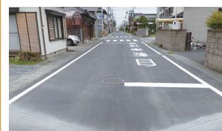
2. 真壁町真壁施工事例
