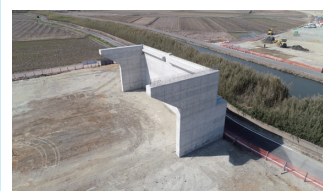
2. 潮来市東関道橋梁下部工事
